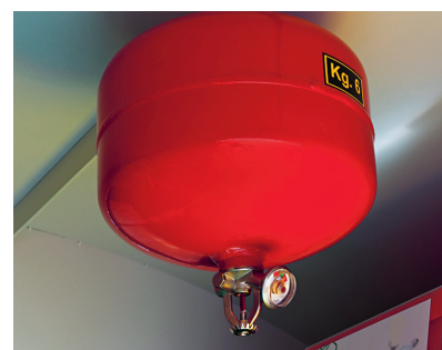
Sprinklersystem för ökad säkerhet.
